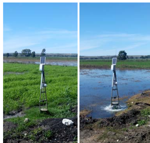
Flood Automation, Mypolonga SA
